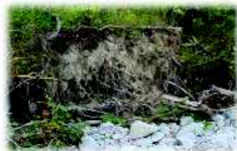
PHOTO 28 - LES BERGES ÉRODÉES
