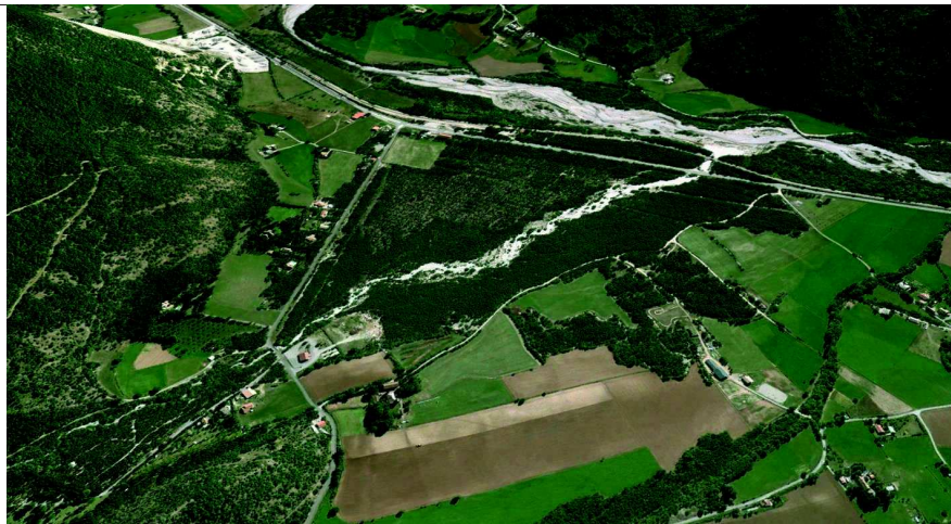
VUE AERIENNE « EN OBLIQUE » DU SITE
