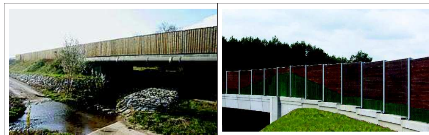
Exemples d'écran de protection à installer au niveau du pont traversant la RD994
