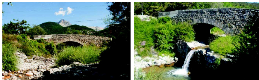
Le pont au-dessus de la Sigouste, le seuil (à droite) présent en aval du pont constitue une véritable rupture dans les continuités écologiques
