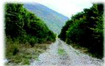
PHOTO 29 - UNE PISTE QUI SUIV UNE CONDUITE DE GAZ
