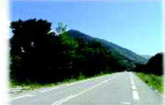
PHOTO 32 - LA RD 994 AU SUD DU PÉRIMÈTRE IMMÉDIAT
